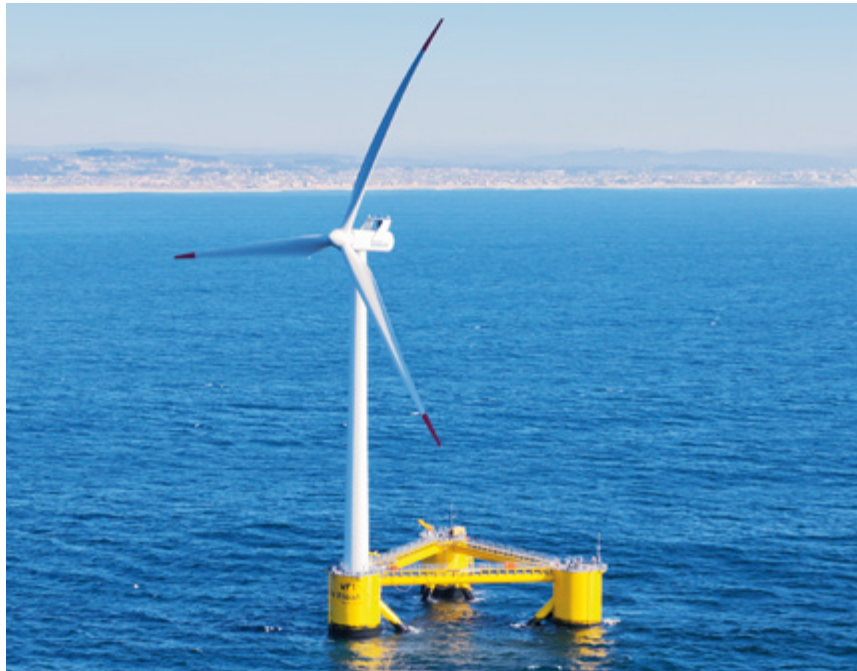
Grösstes schwimmendes Windrad 2015: 7 Megawatt Leistung – bei genügend Wind.
