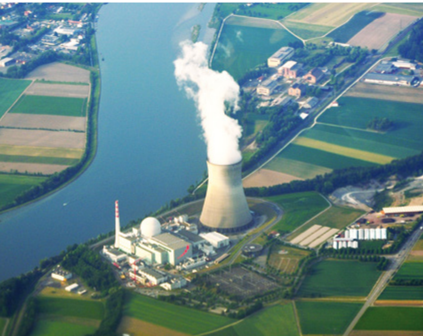
KKW Leibstadt 1984: 1275 Megawatt Leistung – 7 x 24.
